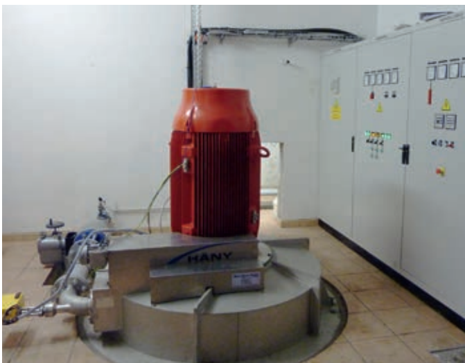
Barcelonnette (France), le turbogroupe, réalisé par Blue Water Power AG, sur la base d'un profil hydraulique Mhylab (Q = 40 l/s, Hn = 551 m, Pm = 192 kW)
