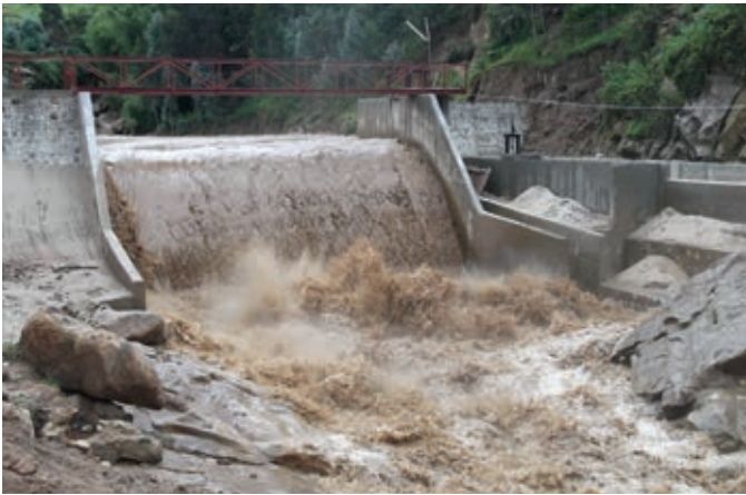
Giciye, Rwanda – Prise d'eau durant une crue
