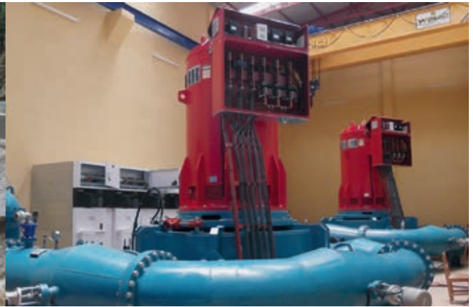
Giciye, Rwanda – Groupes Pelton fournis par la société Gugler durant la mise en service
