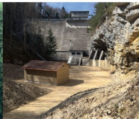
Le Day: le local de turbinage au pied du barrage
