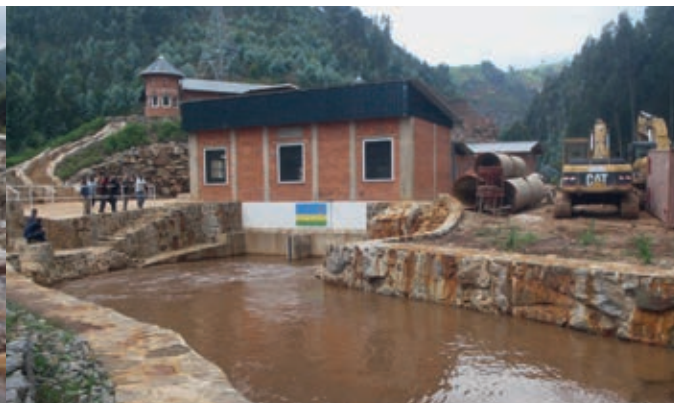
Centrale de Rukarara II, Rwanda
