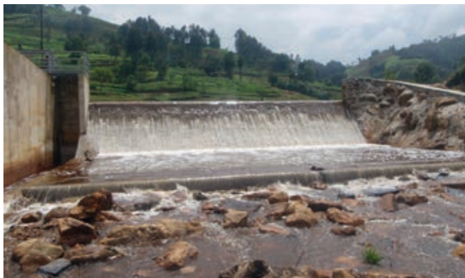
Seuil sur la Rukarara, Rwanda
