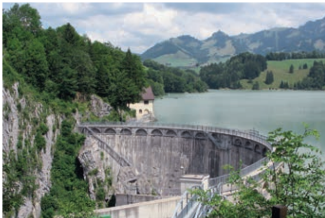
Barrage de Montsalvens (CH)
